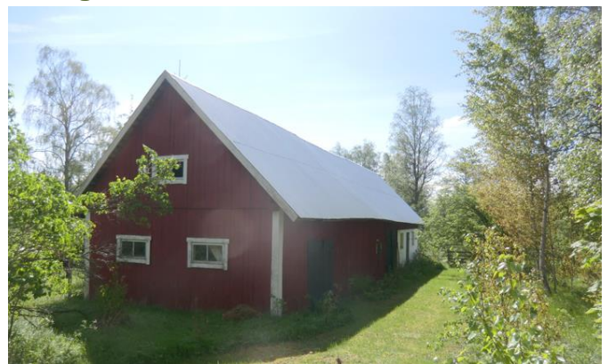
Ladugård under tak med plåt. El finns.
