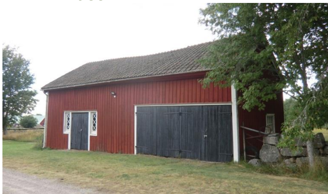
Garage, stensatt grund med stomme av trä, grus/gjutet golv. El finns.
